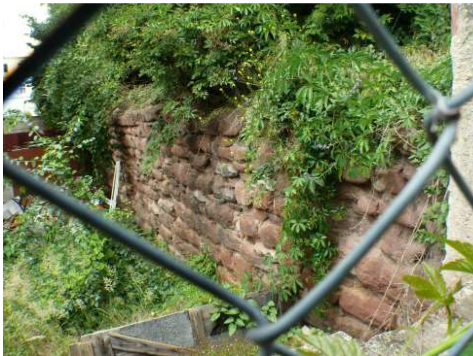
Obr. 14: Český Brod, nová sportovní hala. Úsek hradby přiléhající k sondám I a II z vnější strany. Vzadu je hradba zřetelně vykloněna. Pohled od jihu. Foto P. Pinc.
